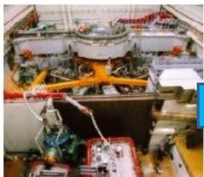
H21年10月(解体前)
