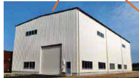
真空容器組立棟竣工 那珂核融合研究所内
