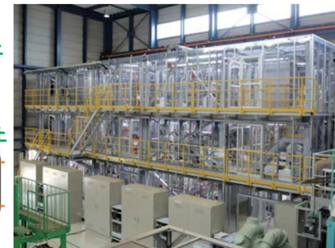
連続水素製造試験装置
