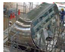
真空容器(40度部分)
