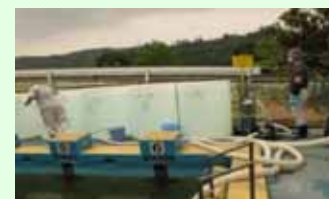
ゼオライトによるプールの除染 (伊達市での作業の様子)
