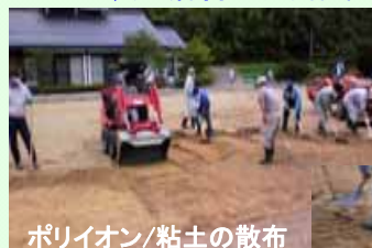
ポリイオン/粘土による表土層剥ぎ取り作業
