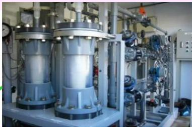
例) セシウム高分子捕集材と浄化システム
