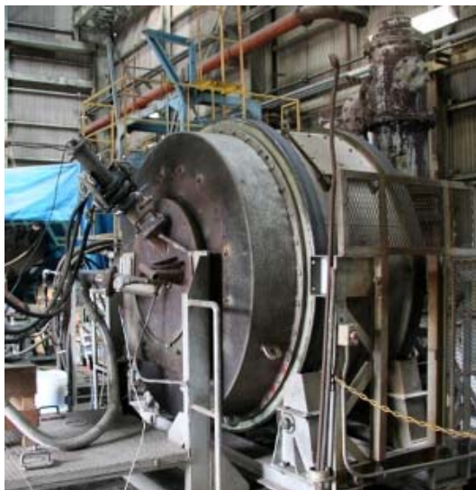
仮焼テスト炉
