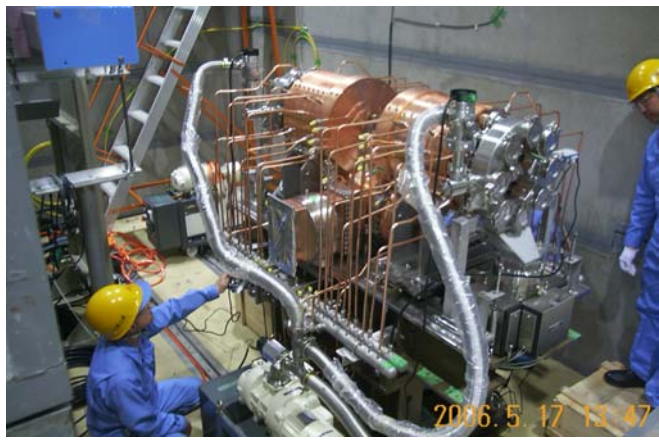
大電力高周波投入準備中の高周波加速空洞原型機
