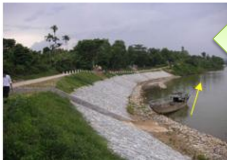
河岸侵食対策の試験施工 (ベトナム)
