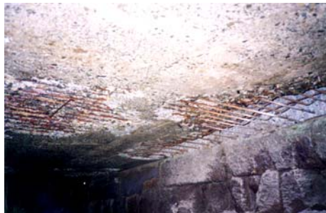
下水道管渠頂版
