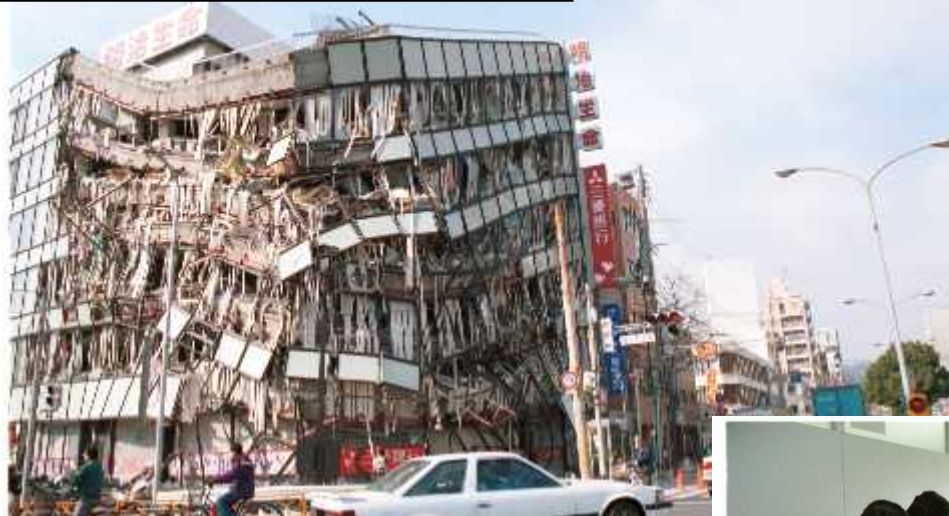
壊れないと思っていたビルが倒壊
