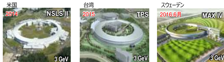
(目標)0.55→(実効性能)1.5 nm·rad (目標)1.6→(実効性能)1.6 nm·rad (目標)0.33→(実効性能)- nm·rad
