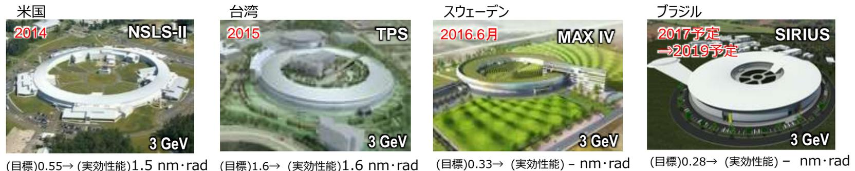
⇒ 硬X線向け施設と単純比較はできないが、SPring-8のエミッタンスは2.4 nm·rad。
