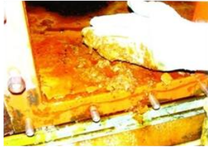
オイルタンクに溜まったスラッジ
