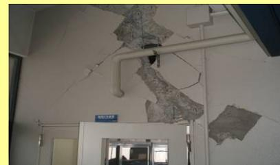
地震により亀裂が入り、剥がれ落ちた壁
