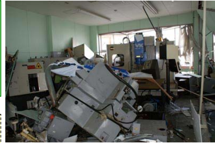
建物内部の被災状況
