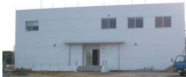
図6 イプシロン管制センターの新設
