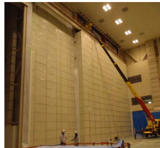
(図4) 総合環境試験棟 「工事用飛散防止パネル」を使用した仮設壁 (仮設クリーンルーム室内側)
