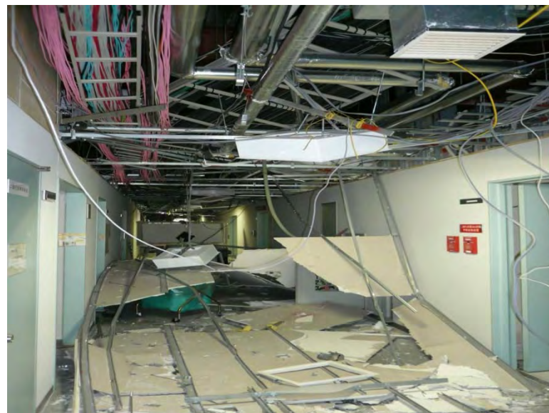
(図D) 宇宙ステーション運用棟 4階廊下電気ケーブルダクト・天井破損落下
