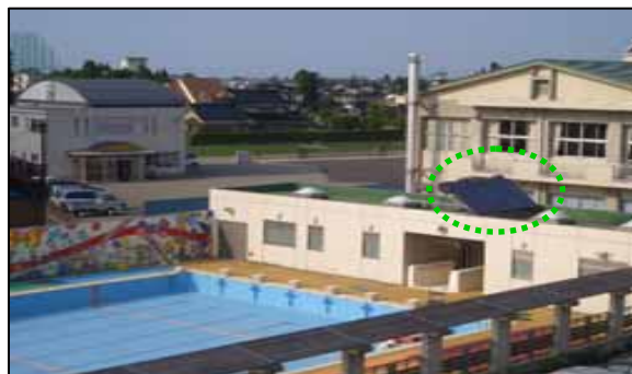
太陽熱利用 太陽熱をプールの温水シャワーに利用
