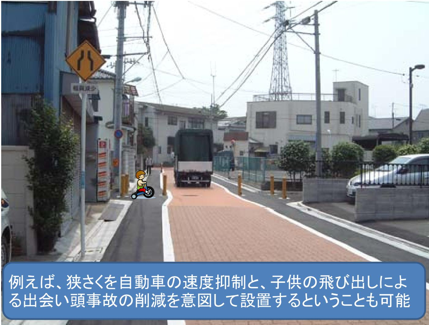
例えば、狭さを自動車の速度抑制と、子供の飛び出しによる出会い頭事故の削減を意図して設置することも可能
