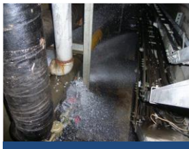
配管の破損による水漏れ
