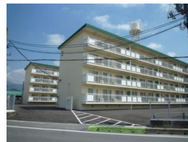
借用によるスペースの確保 YU国際シェアハウス (山口大学)
