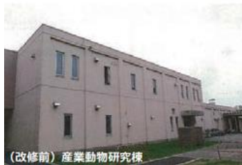
(改修前) 産業動物研究棟
