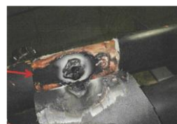
特別高圧ケーブル故障
