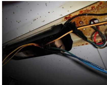
照明安定器破損
