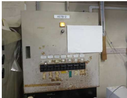
実験盤の劣化
