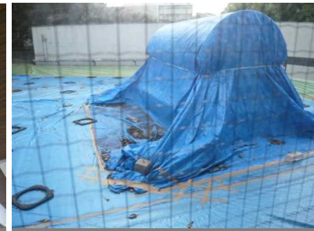
屋上防水の応急処置
