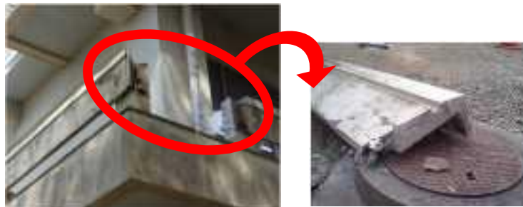
老朽化により手すりが落下
