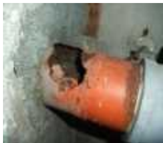
劣化による配管破損
