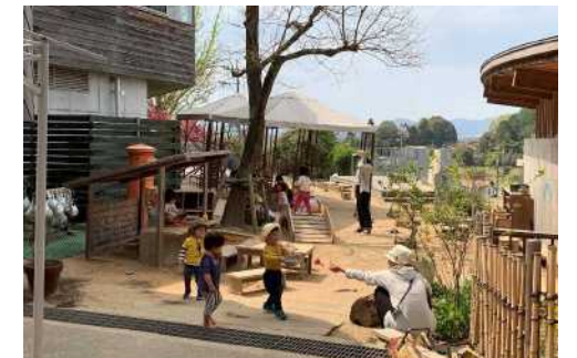
水の棟（子育て支援棟）と吹の棟（保育室）に挟まれた0～2歳児用の園庭。水の棟から子どもが遊んでいる姿を見ることができ、緩やかなつながりを感じられる。
