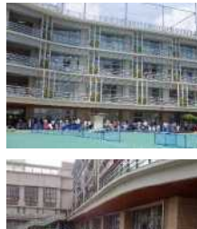
2階（小学校）バルコニーが1階にある幼稚園の庇となることで、雨天時の半屋外空間として、また、保護者の送迎時のたまりの場として有効に機能している。
