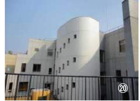
▲棟中央の階段室。柔らかない曲線が空間に大きな変化を与えている。
