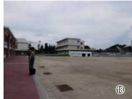
▲グラウンド。災害時に活用可能なかまどベンチや外部から直接利用できるトイレなども配置。
