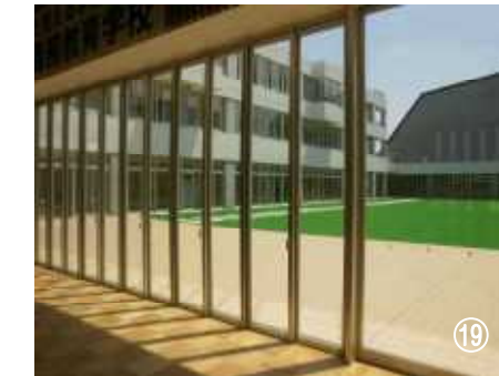
▲「イベント広場」。周囲に接する多目的室や体育館、南北棟廊下の建具は全面開放が可能となっており、広場と一体的に利用することで多様な活動に対応できる計画となっている。
