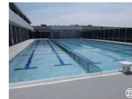
▲体育館に隣接して配置されたプール。水深の違う2面に分けられている。
