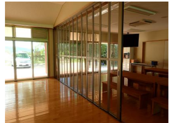
▲遊戯室と多目的室を隔てる可動式間仕切り、 開放すると部屋を一体的に使用可能
