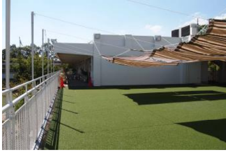
▲屋上庭園（きたかん3階）
