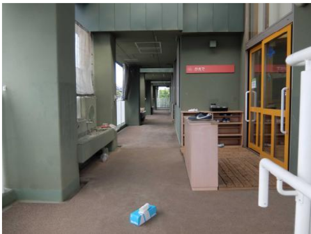
▲各教室に直接アクセスする半屋外の廊下
