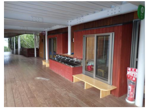
▲渡り廊下のたまり場となる ベンチ・手洗い
