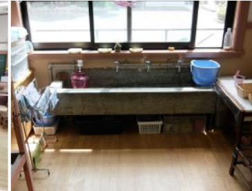
▲保育室内の流し。人研ぎは建設当時のものを活かして再利用している。
