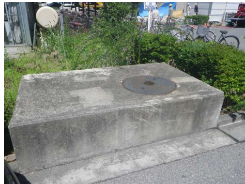
飲用井戸（構内計2基）
