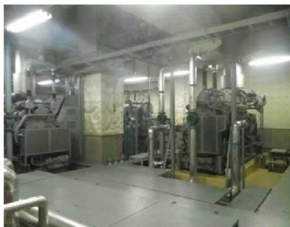
自家発電機設備 ・発電機 1,000kW, 800kW, 700kW
