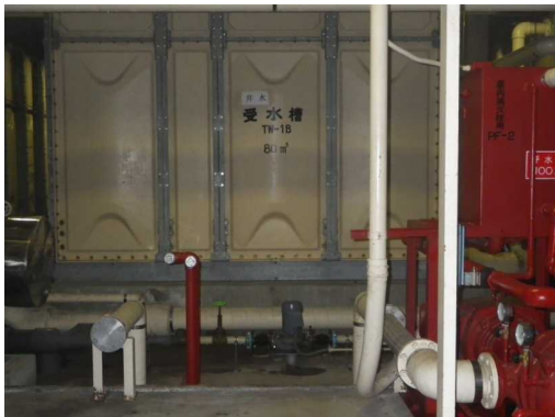
受水槽（井水）80m 3 ×4基=320m 3
