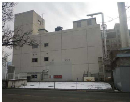
中央機械室外観
