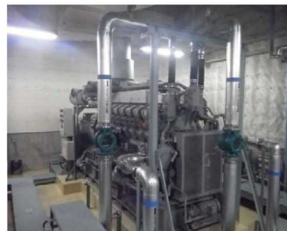
自家発電機設備 ・発電機 1,000kW
