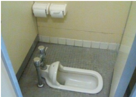
【トイレ】 明るく、快適な洋式トイレ 改修前
