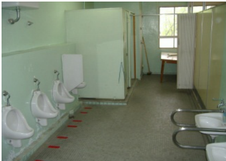
【トイレ】 明るく、きれいな男子トイレ 改修前
