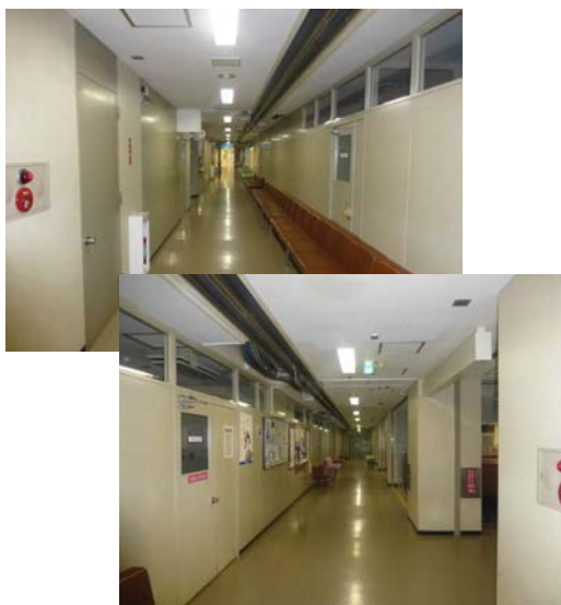
<再整備前> 外部に面した窓のない待合
