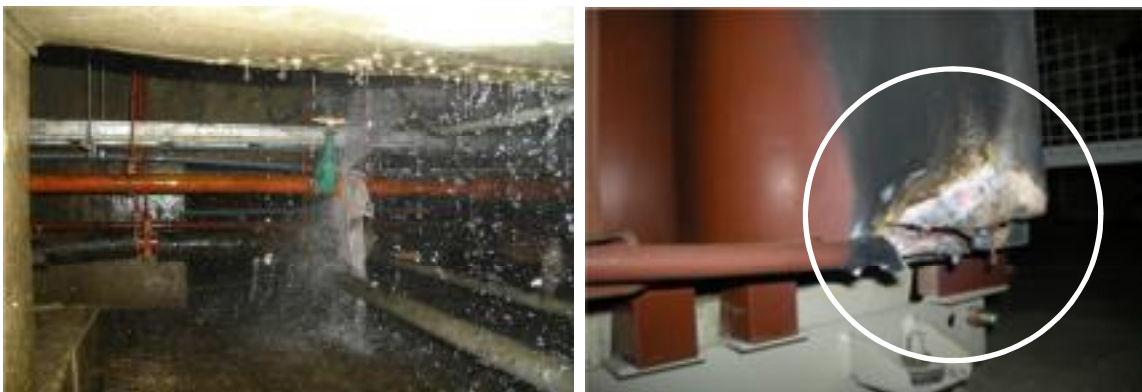
基幹設備（ライフライン）の老朽化の状況（給水管からの漏水（左）、変圧器の発火による損傷（右））
