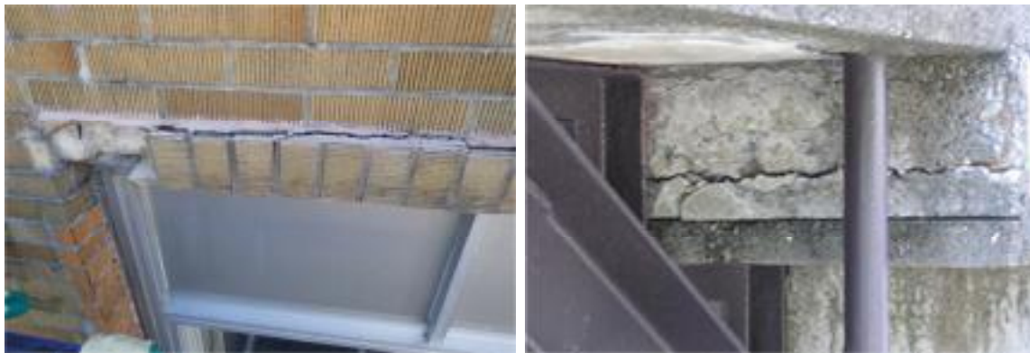
校舎外壁等の老朽化の状況（校舎外壁タイルの浮きやひび割れ（左）、外部階段のひび割れ（右））
