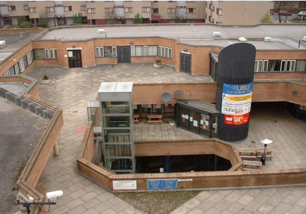
古い建物の中庭を改修して内部化
