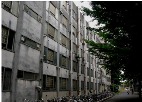
老朽施設の外觀(築48年)(東工大)
