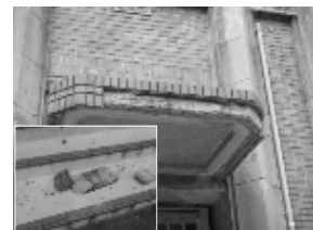
▲外壁タイルの剥落
