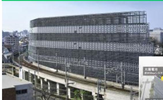
地震エネルギーを吸収する外郭構造(制震ブレース)の採用により、将来の首都圏直下型大型地震にも耐える高い耐震性能を確保
