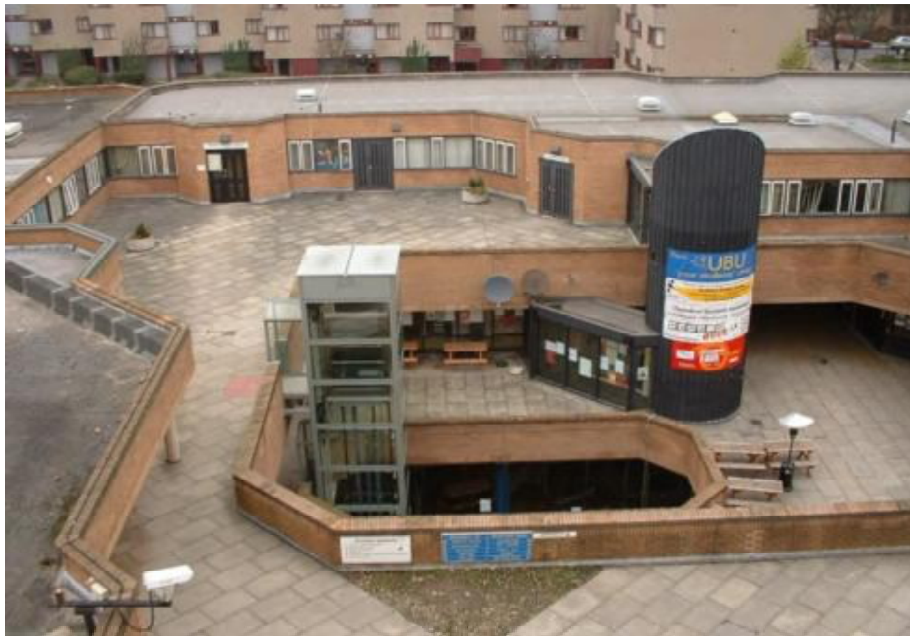
古い建物の中庭を改修して内部化
