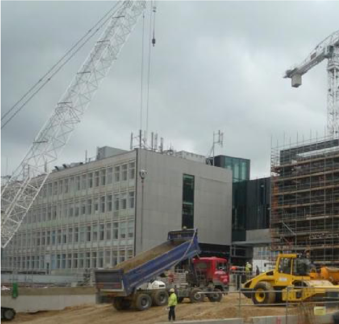
古い建物に並行して吹抜を介した新棟を増築
