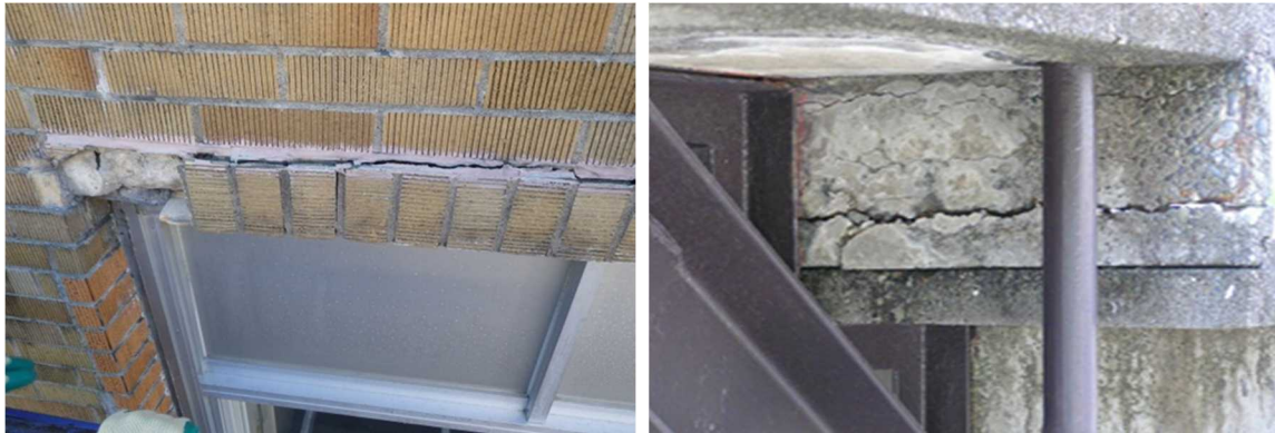
校舎外壁等の老朽化の状況（校舎外壁タイルの浮きやひび割れ（左）、外部階段のひび割れ（右））
