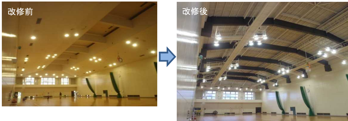
図表 1 7 非構造部材の耐震対策（天井材の撤去）
