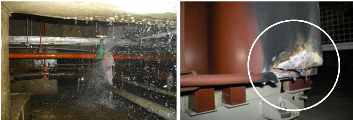
基幹設備（ライフライン）の老朽化の状況（給水管からの漏水（左）、変圧器の発火による損傷（右））
