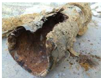
劣化により腐食・破損した排水管
