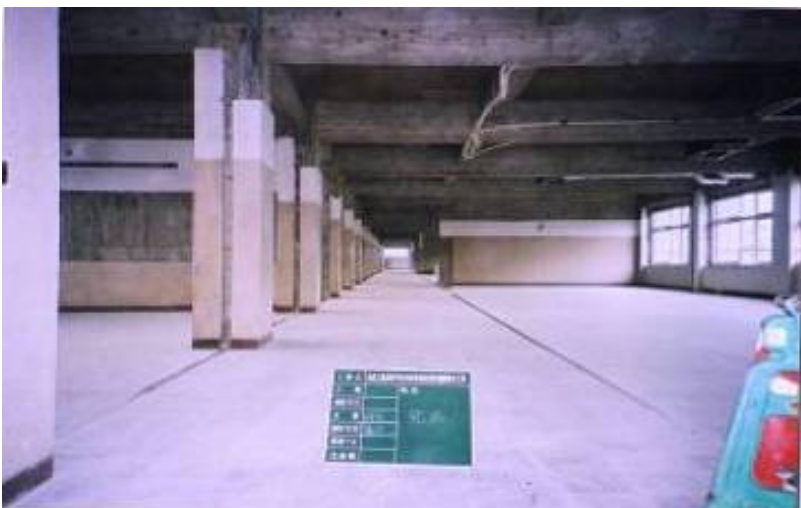
(3) 躯体劣化部補強完了
