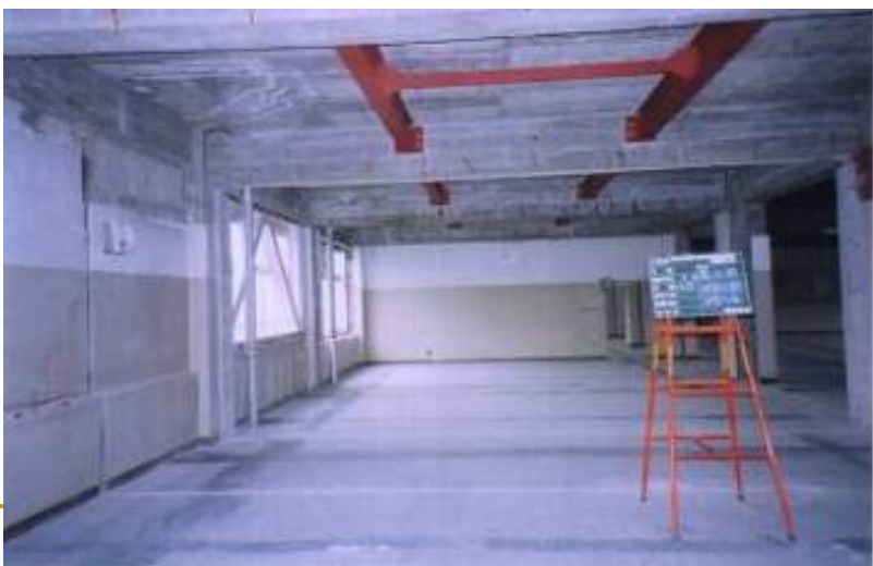
(3) 躯体劣化部補強完了
