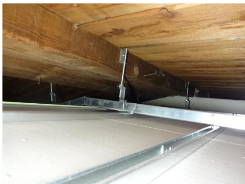
対策前の天井懐内部（屋根下地が木製）
