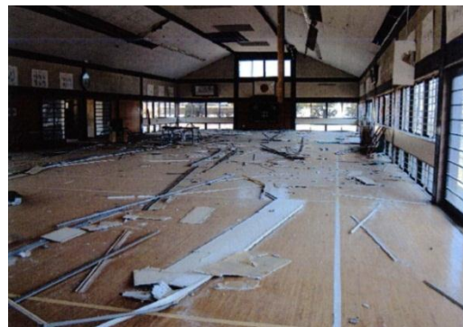
写真4: 中学校(茨城県茨城町/格技場)
