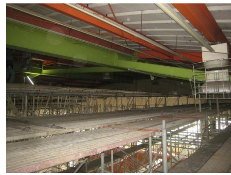
施工中(梁塗装・照明は付替)
