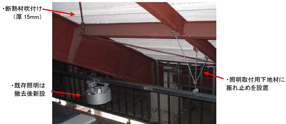
照明設備等の施工状況
