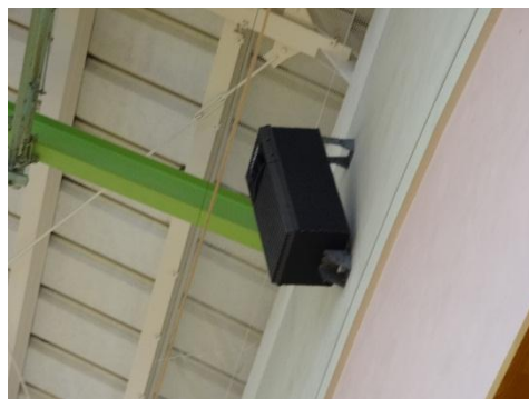
妻側の壁面頂部にネットを設置
