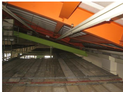
施工中(既存吊りボルトは斜め方向)
