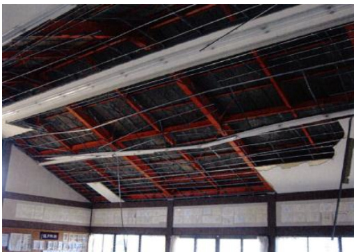
写真3: 中学校(茨城県茨城町/格技場)
