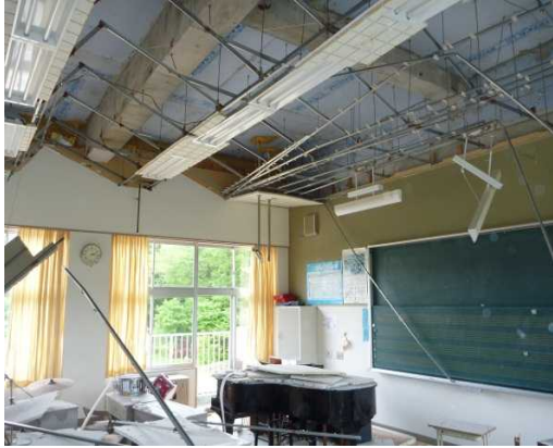
写真 11 段差・折れ曲がり天井の脱落
