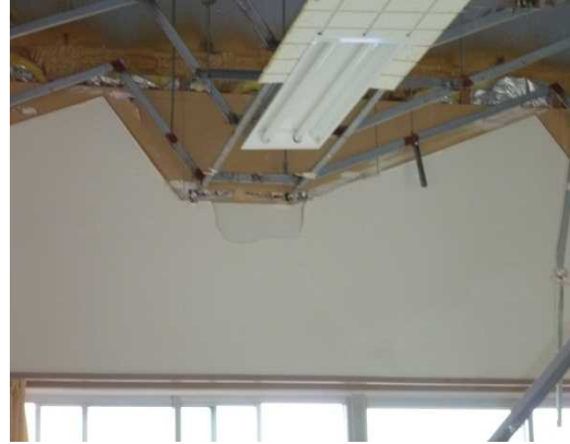
写真 11 段差・折れ曲がり天井の脱落
