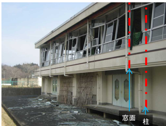
写真 6 桁行面の窓と柱の関係 (例)
