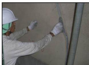
コンクリートブロック外壁の転倒防止対策
