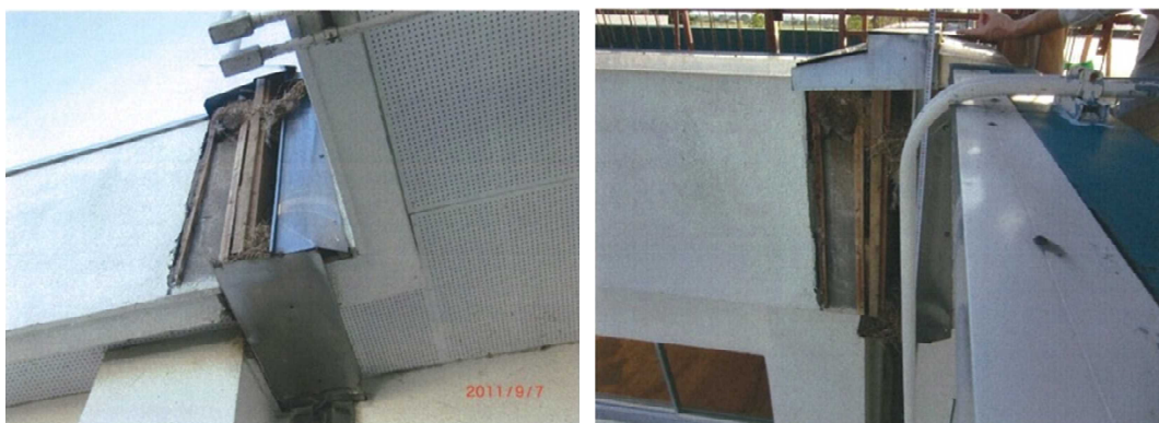
(宮城県登米市／中学校／RC造／校舎／1974年)
