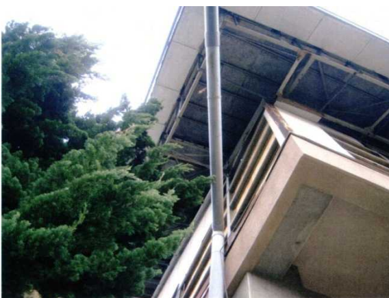
高等学校／茨城県銚田市／上層部がS造・下層部がRC造／1973年
