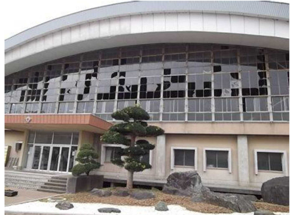
高等学校／茨城県銚田市／上層部がS造・下層部がRC造／1973年
