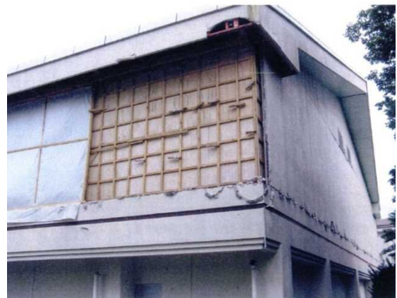
小学校／茨城県常陸太田市／上層部がS造・下層部がRC造／1987年
