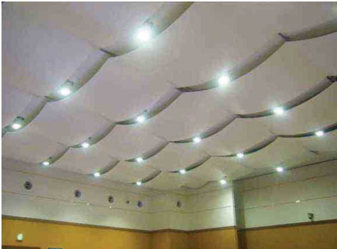
復旧状況(ガラス繊維幕工法) H24.5.25撮影
