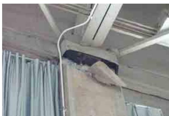
鉄骨屋根定着部コンクリートの破壊
