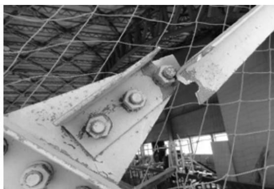
保有耐力接合されていないプレース端接合部の破断
