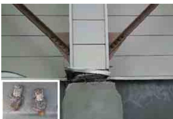
柱脚アンカーボルトのねじ部破断
