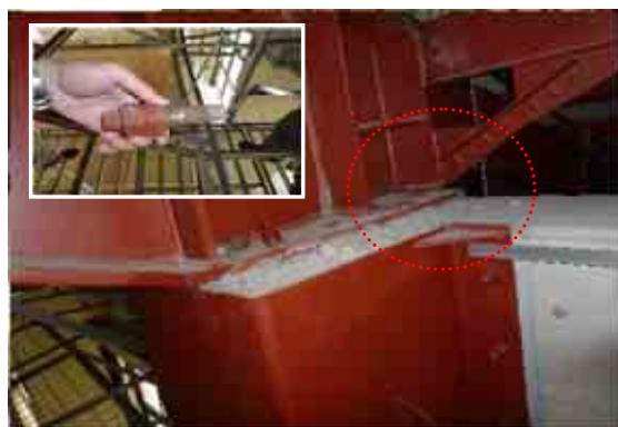
屋根定着部アンカーの破断
