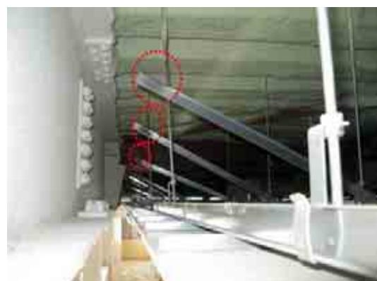
斜め部材の溶接が外れた被害
