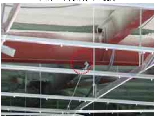
H形鋼梁への吊り金具が外れた被害
