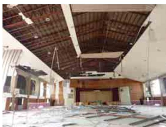
在来工法による天井の地震被害
