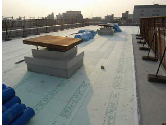
太田市立中央小学校(屋根断熱)
