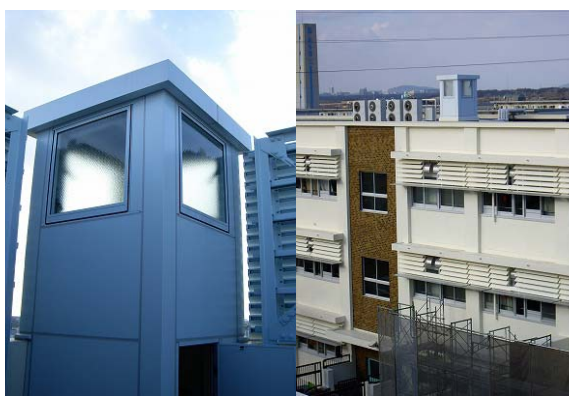
神戸市立多聞東中学校(階段室上部)
