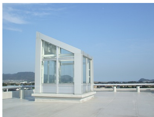
北九州市立曽根東小学校(屋上)
